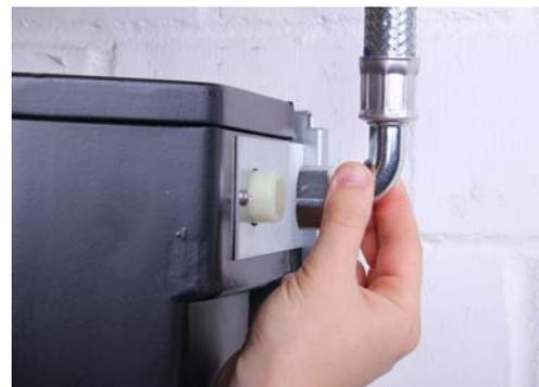
Visser l'autre côté du tuyau flexible au robinet d'arrêt monté à la conduite d'eau potable.
