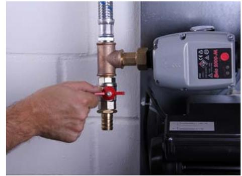
5. Ouvrir la vanne d'arrêt sur conduite de départ vers points utilisateurs avec manomètre et purger les conduites (par exemple en faisant fonctionner plusieurs fois la chasse d'eau et en ouvrant le robinet d'arrosage du jardin).
