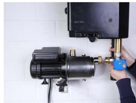
La vanne à flotteur pour l'appoint d'eau dans le réservoir sera vissée sur le réservoir.
