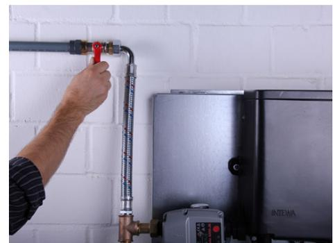
3. Ouvrir la vanne d'arrêt avec robinet purgeur d'air.
