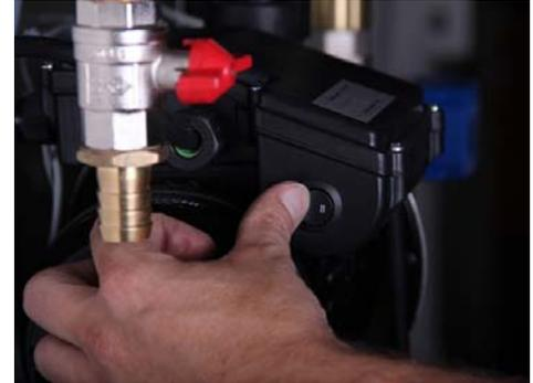
3. Fermer la vanne d'arrêt sur conduite de départ vers les points utilisateurs avec manomètre.
