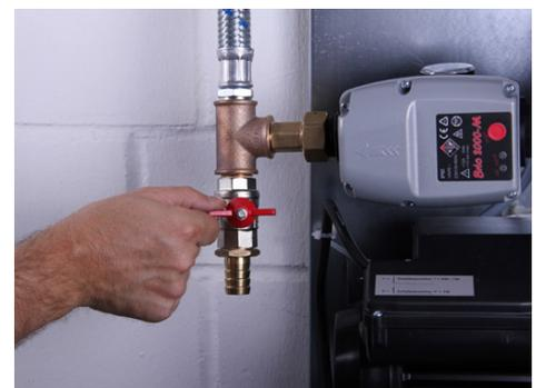
6. Ouvrir la vanne d'arrêt sur conduite de départ vers les points utilisateurs avec manomètre et purger les conduites (par exemple en faisant fonctionner plusieurs fois la chasse d'eau et ouvrir le robinet d'arrosage du jardin).
